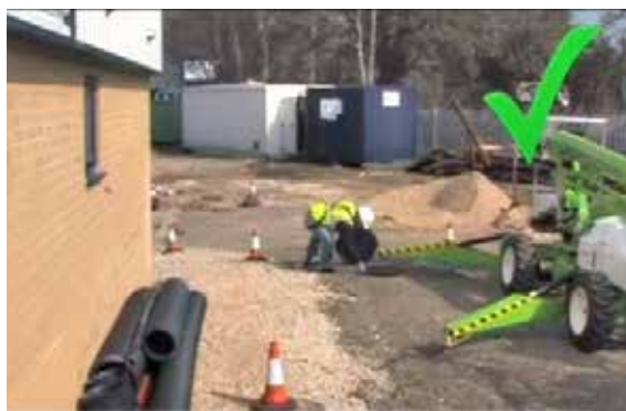
Figura 23. Evaluación previa de las condiciones de terreno.
