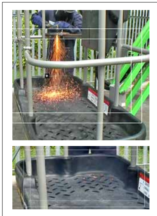
Figura 5. Base de la plataforma de trabajo autoextinguible.
